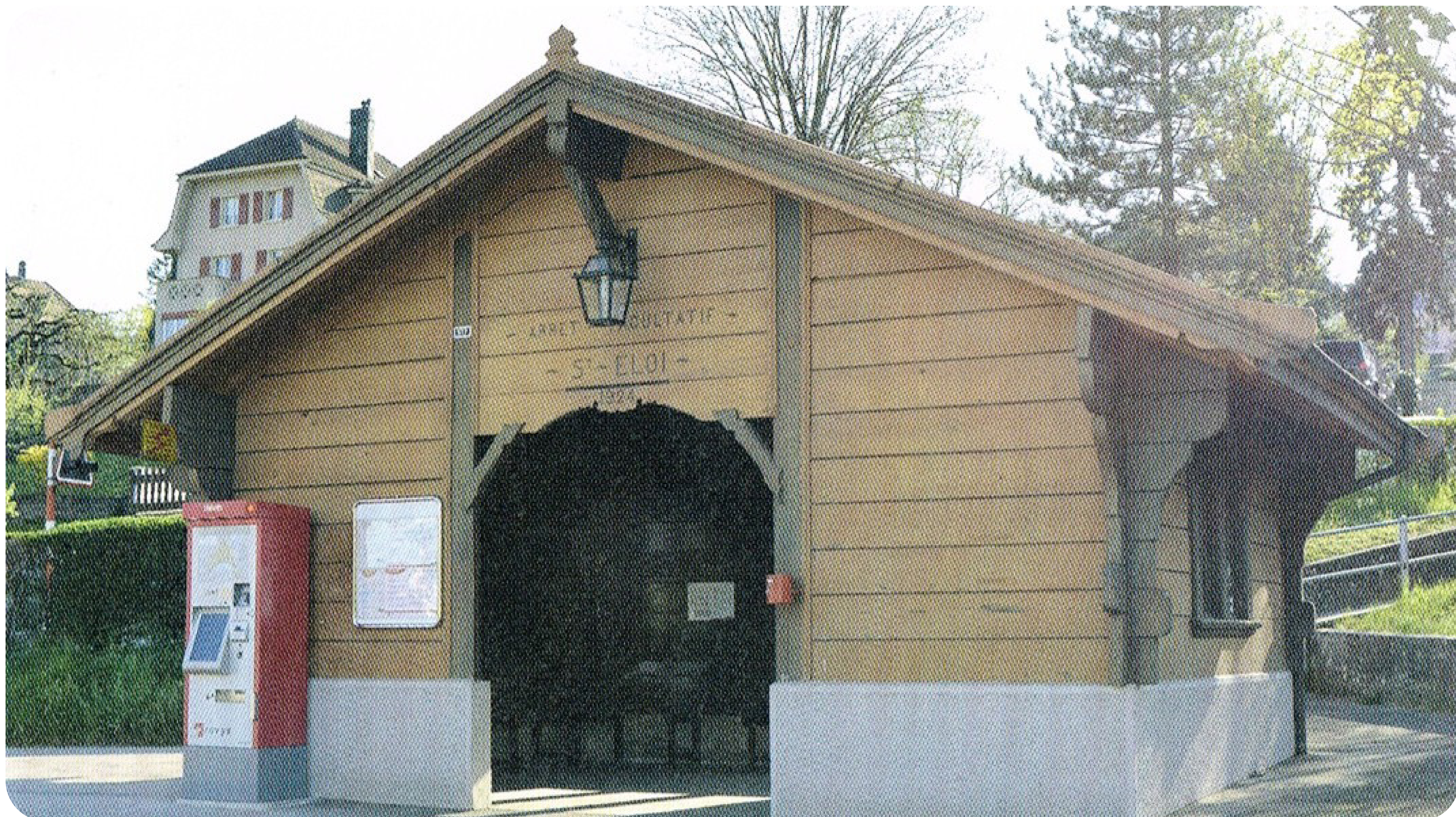
Halte de St-Eloi construite en 1924, image issue de l'ouvrage « Orbe, Histoire et Architecture », Laurent Auberson
